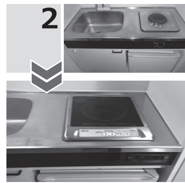
IHコンロの設置前(上)、設置後(下)
