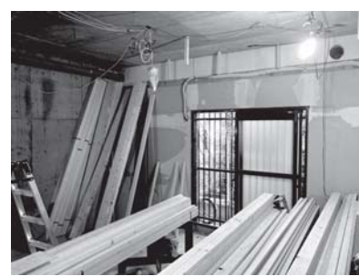
自社物件リノベの様子。この物件分の木材調達はできたが、次の物件は一時中断。下地の一部を木材とLGS(軽量鉄骨)を併用も可能ですが、材料の膨張率・伸縮率の違いで、数年後に反りや割れが生じます。
