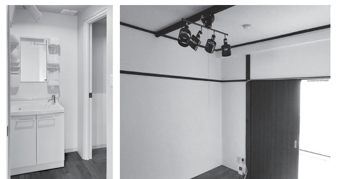
左・照明がONの状態の洗面室、清潔な印象を与えます。 右・室内にダウンライト設置、印象がガラッと変化します。計画的に照度、輝度、配光、色温度、スイッチ制御などを考慮し、担当の工事業者と相談しましょう。
